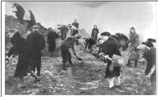
Bau von Verteidigungsanlagen bei Premnitz
